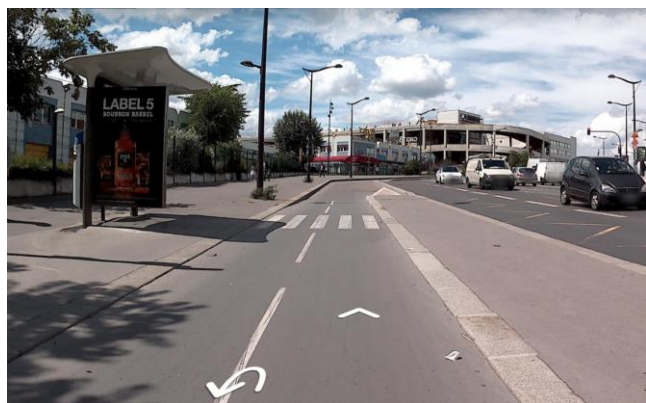
Figure 3 : Exemple d'aménagement d'un quai bus derrière la piste cyclable (source : Mapillary / Paris)
